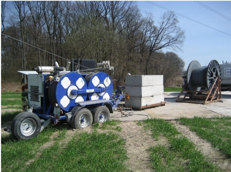
Abb. 10: Windenplatz eines 4er-Bündel-Seilzuges
