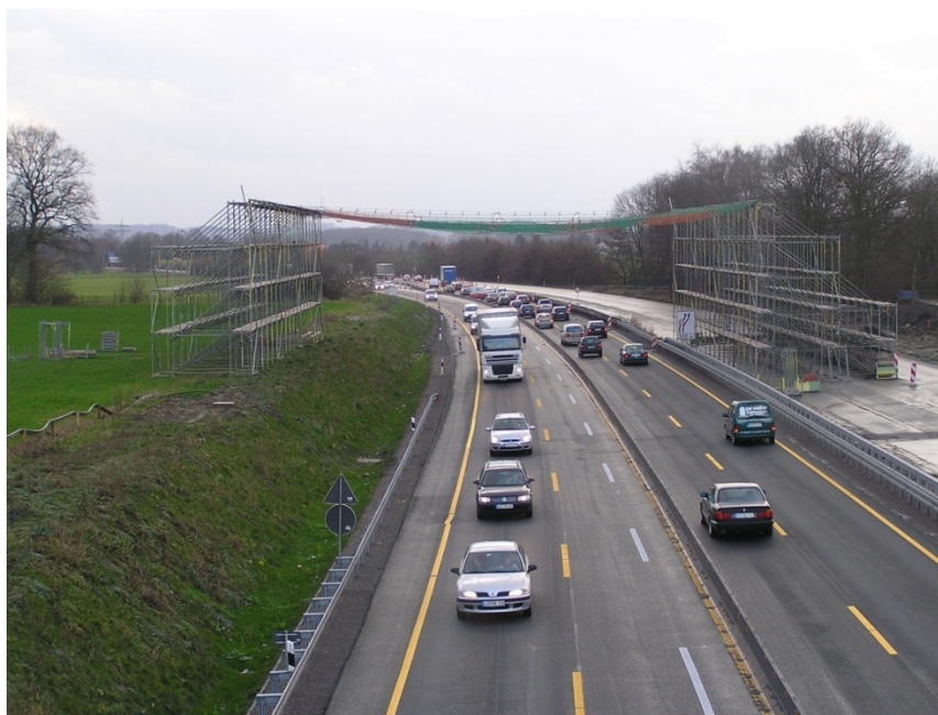
Abb. 9: Stahlrohrschutzkonstruktion mit Netz über einer Autobahn
