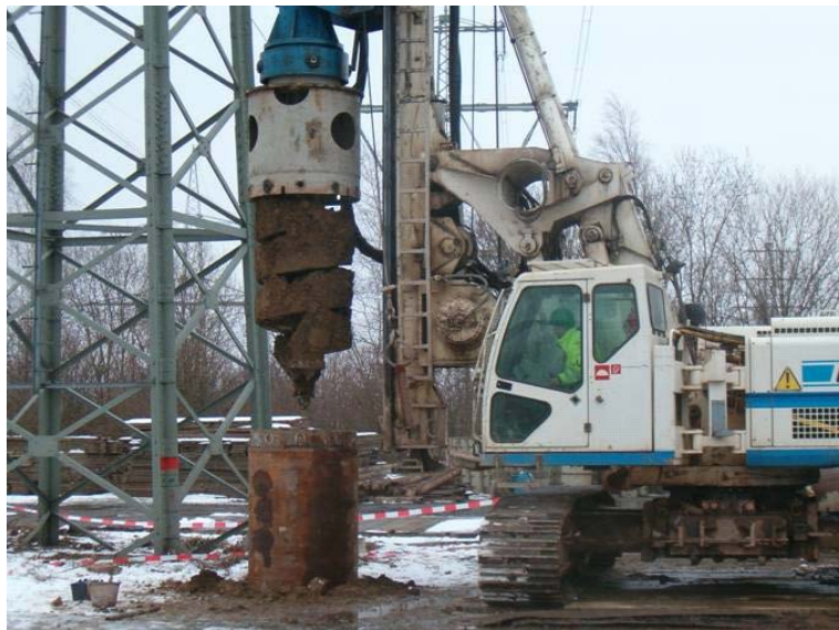
Abb. 5: Bohrung für einen Bohrpfahl
