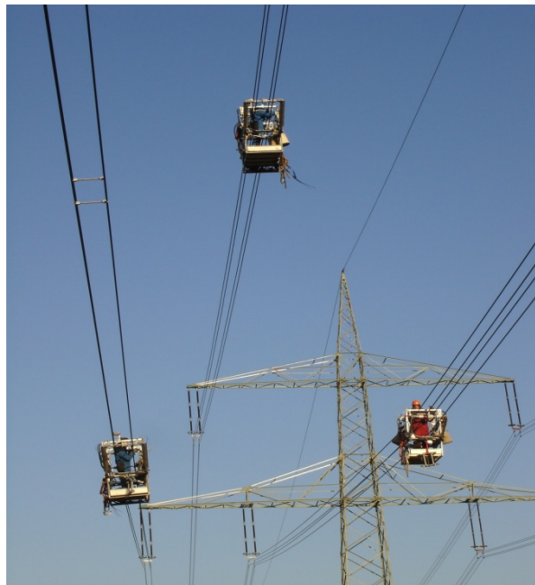
Abb. 11: Montage der Feldbündelabstandhalter mit Fahrwagen
