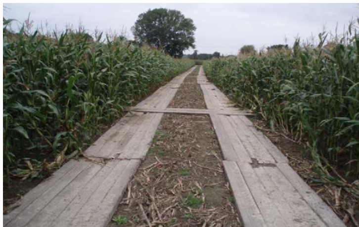
Abb. 3: Temporäre Zuwegung über Fahrbohlen
